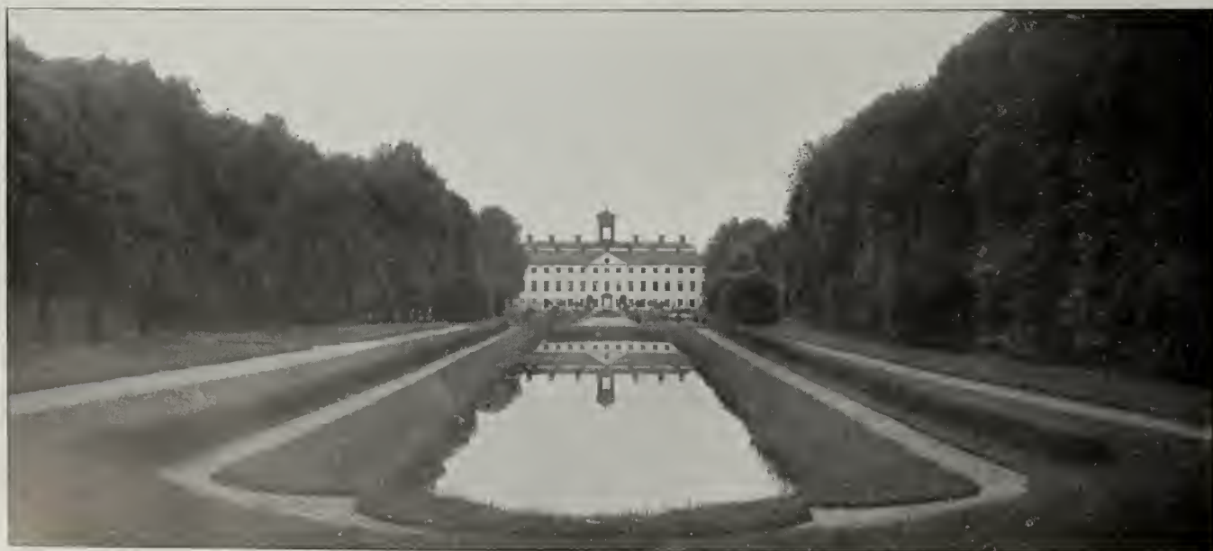
Slottet med spegeldammen från parksidan.
